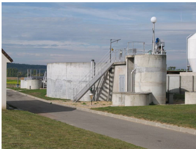
Vue d'ensemble de la station d'épuration
