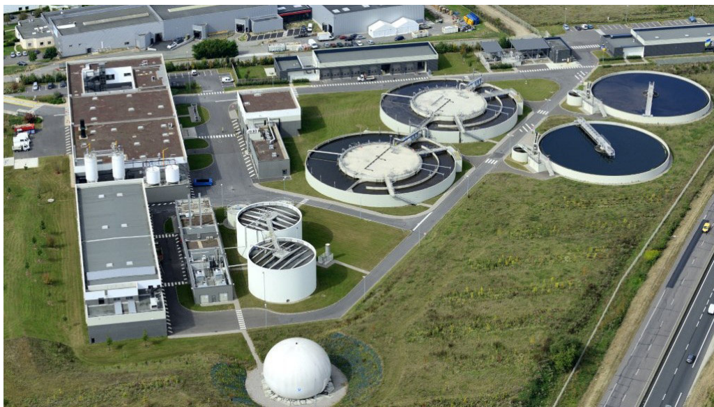
Vue générale du CTEU. (centre de traitement des eaux usée d'EPN à Gravigny), [axe est / ouest]
