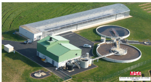
Vue aérienne de la station d'épuration
