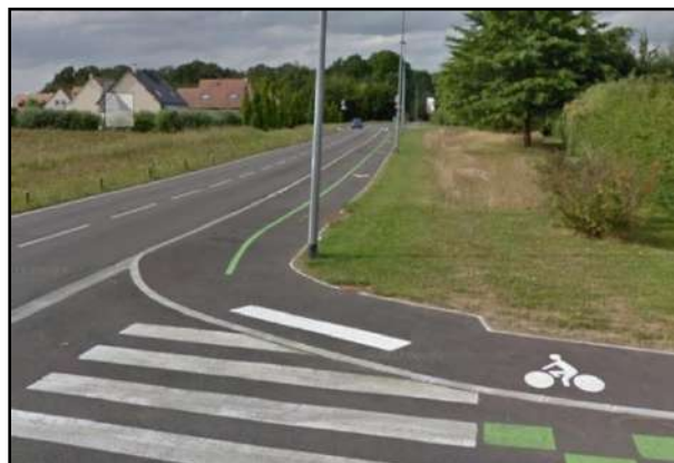
Figure 68 : Piste cyclable éparée de la chaussée, rue d'Aviron (Evreux). (Source : Google Maps)
