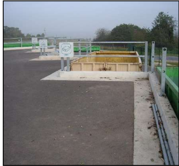
Figure 73 : Déchèterie Arnières-sur-Iton. (Source : Évreux Portes de Normandie)
